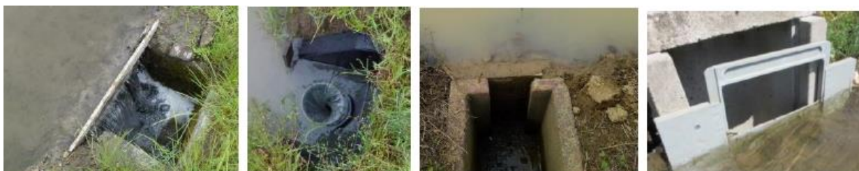
隙間から水漏れ
