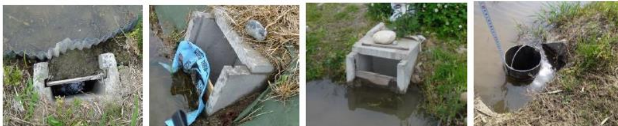
水口の高さが十分で水漏れの無い鉄壁な水尻
